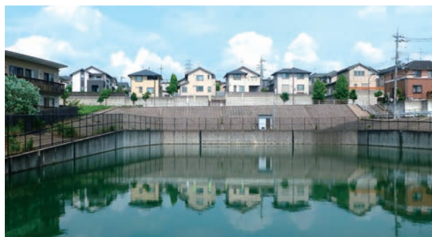
図6 分かり易い盛土造成地。谷の末端に貯水池を作り、背後の谷を埋め立てて宅地になっている。
