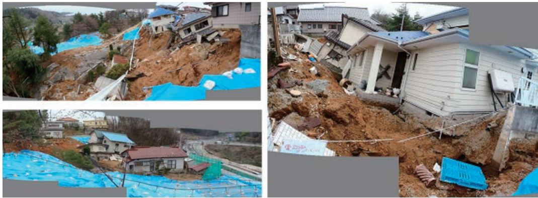
図2 福島市あさひ台団地の被災状況。写真提供：太田英将氏（有限会社太田ジオリサーチ）。
